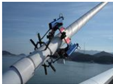
【 교량 케이블 점검 로봇 】
