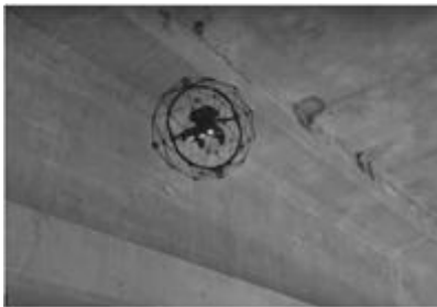
【 교량 점검 드론 】
